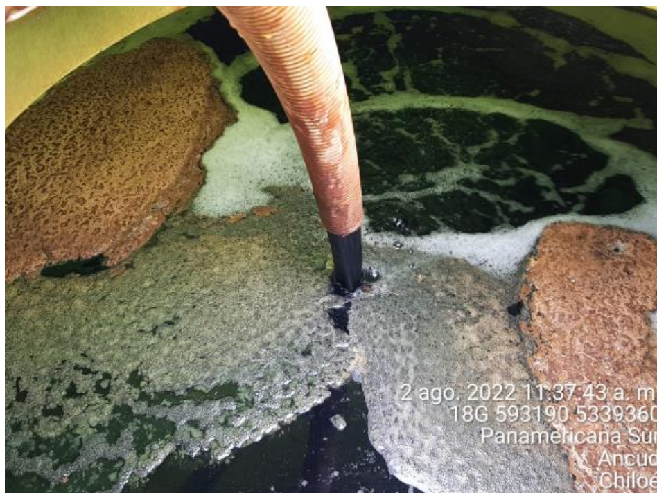
Fotografía N°6: Extracción de Lixiviados a estanque por personal municipal. Tomada: Martes 02 de Agosto del 2022.
