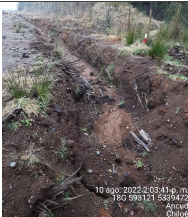
Fotografía N°58: Estado canales aguas lluvias
