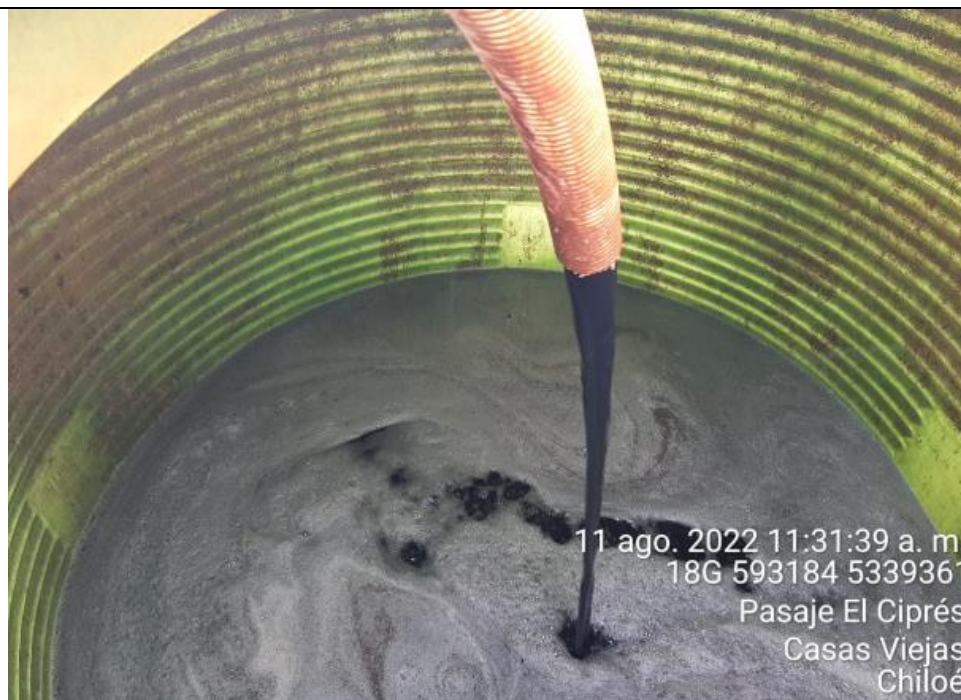
Fotografía N°31: Extracción de Lixiviados a estanque. Tomada: Jueves 11 de Agosto del 2022.
