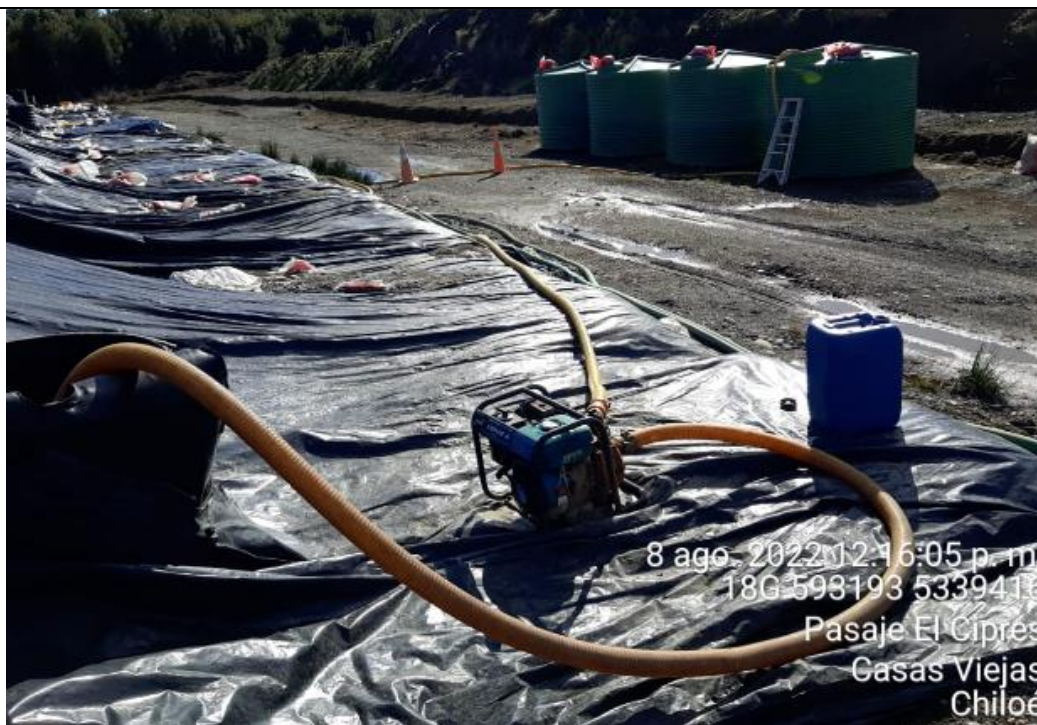
Fotografía N°23: Extracción de Lixiviados desde Cámara C13. Tomada: Lunes 08 de Agosto del 2022.
