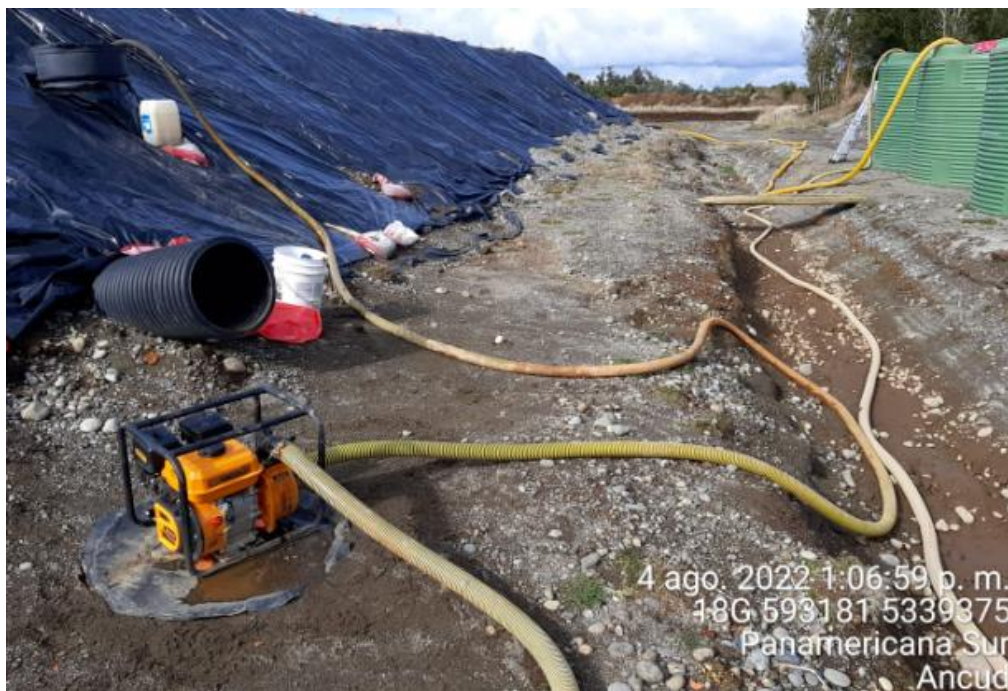
Fotografía N°10: Extracción de Lixiviados desde cámara C02 por personal municipal. Tomada: Jueves 04 de Agosto del 2022.
