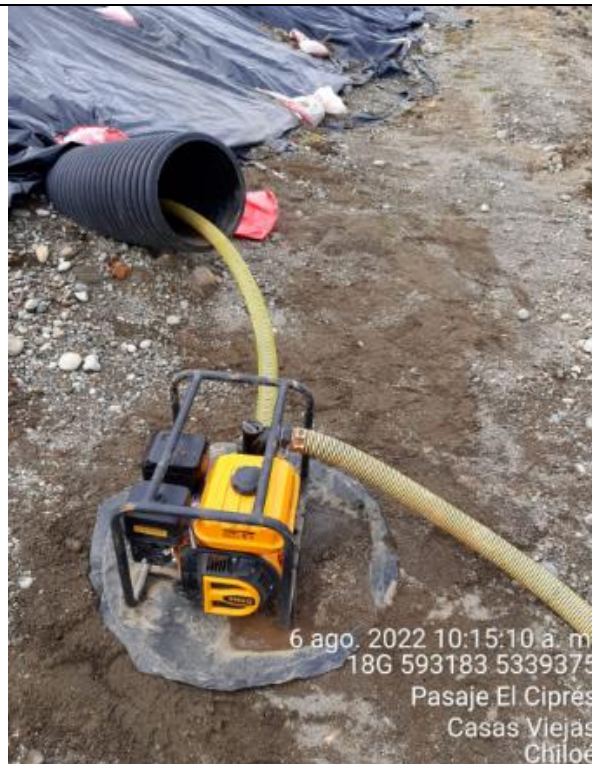
Fotografía N°17: Extracción de Lixiviados desde diagonal D02. Tomada: Sábado 06 de Agosto del 2022.
