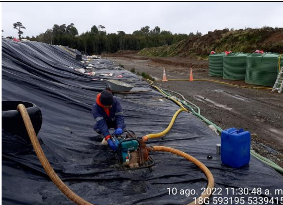
Fotografía N°28: Extracción de Lixiviados desde cámara C13. Tomada: Miércoles 10 de Agosto del 2022.
