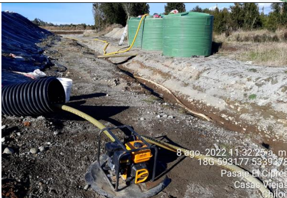
Fotografía N°20: Extracción de Lixiviados desde diagonal D02. Tomada: Lunes 08 de Agosto del 2022.
