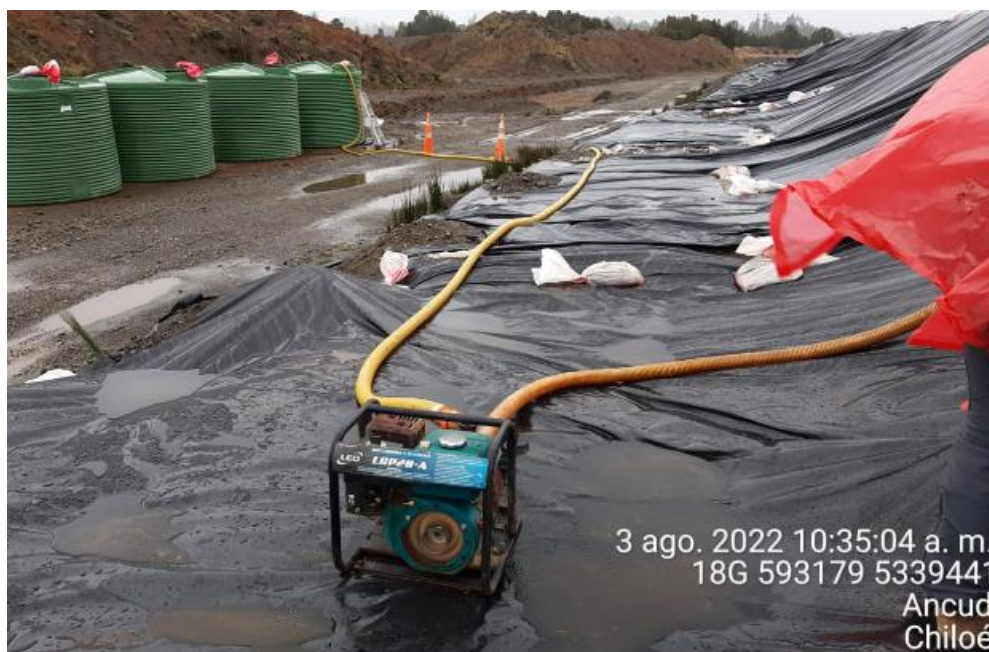
Fotografía N°7: Extracción de Lixiviados desde C12 por personal municipal. Tomada: Miércoles 03 de Agosto del 2022.
