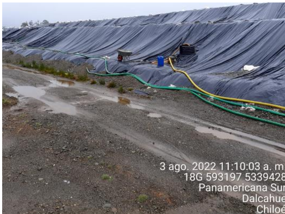
Fotografía N°8: Extracción de Lixiviados desde C13 por personal municipal. Tomada: Miércoles 03 de Agosto del 2022.
