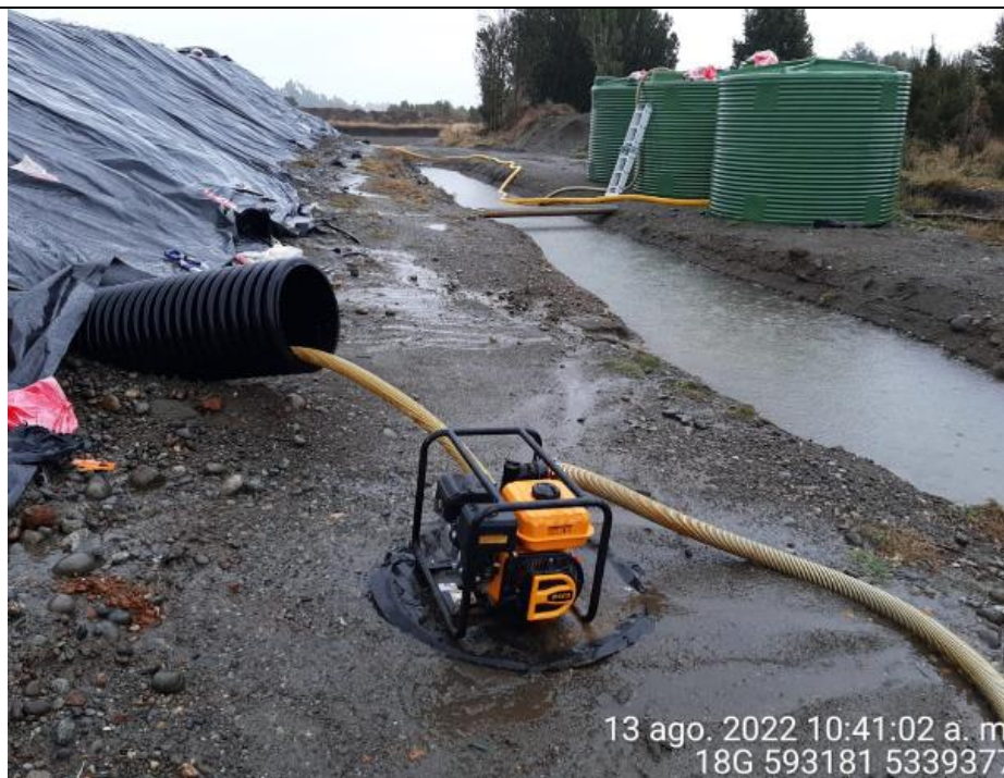
Fotografía N°35: Extracción de Lixiviados diagonal D02. Tomada: Sábado 13 de Agosto del 2022.
