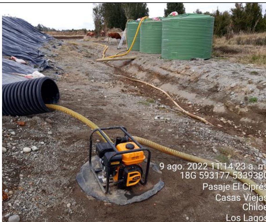
Fotografía N°25: Extracción de Lixiviados diagonal D02 Tomada: Martes 09 de Agosto del 2022.
