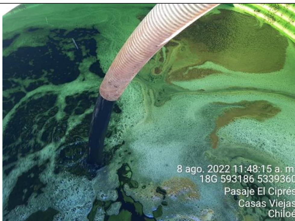
Fotografía N°21: Extracción de Lixiviados a estanque. Tomada: Lunes 08 de Agosto del 2022.
