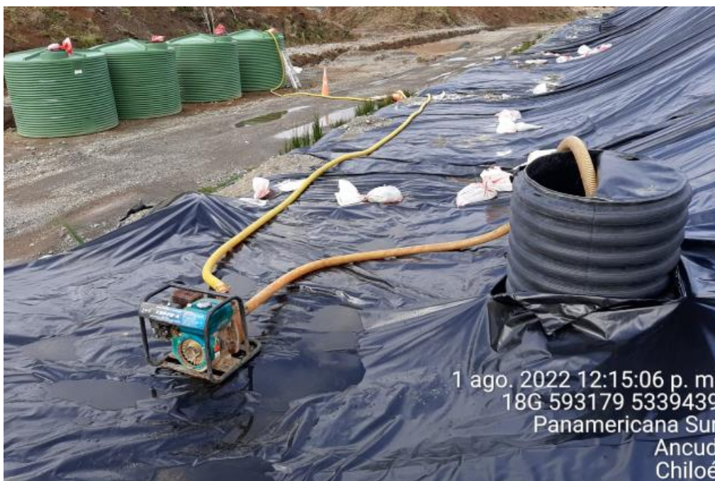
Fotografía N°1: Extracción de Lixiviados desde cámara C12. Tomada: Lunes 01 de Agosto del 2022.
