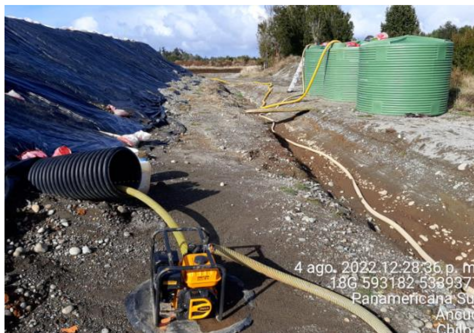
Fotografía N°11: Extracción de Lixiviados desde diagonal D02 por personal municipal. Tomada: Jueves 04 de Agosto del 2022.
