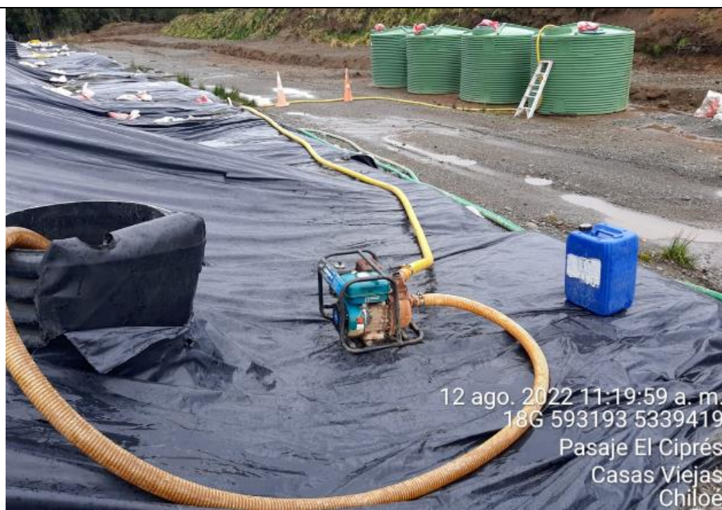
Fotografía N°33: Extracción de Lixiviados cámara C13. Tomada: Viernes 12 de Agosto del 2022.
