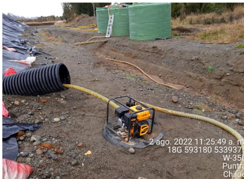
Fotografía N°5: Extracción de Lixiviados desde diagonal D02. Tomada: Martes 02 de Agosto del 2022.
