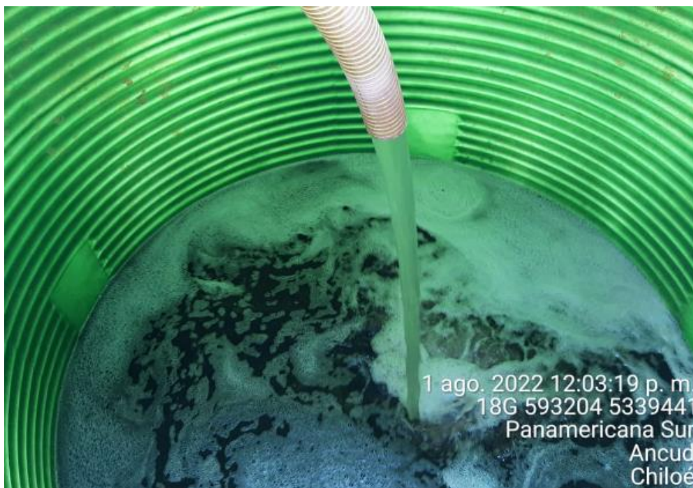
Fotografía N°3: Extracción de Lixiviados a estanque por personal municipal. Tomada: Lunes 01 de Agosto del 2022.
