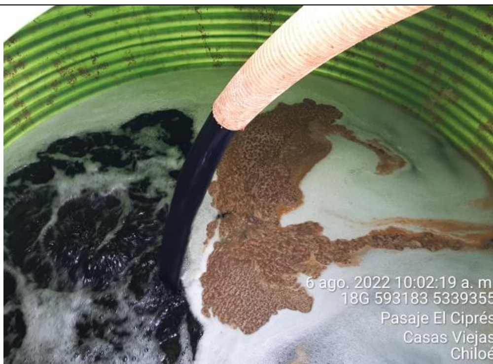
Fotografía N°19: Extracción de Lixiviados a estanque. Tomada: Sábado 06 de Agosto del 2022.
