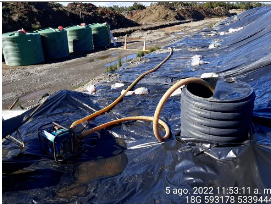
Fotografía N°14: Extracción de Lixiviados desde cámara C12. Tomada: Viernes 05 de Agosto del 2022.
