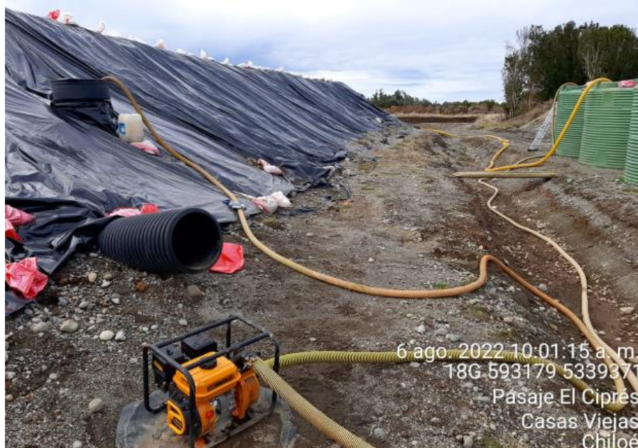
Fotografía N°18: Extracción de Lixiviados desde cámara C02. Tomada: Sábado 06 de Agosto del 2022.
