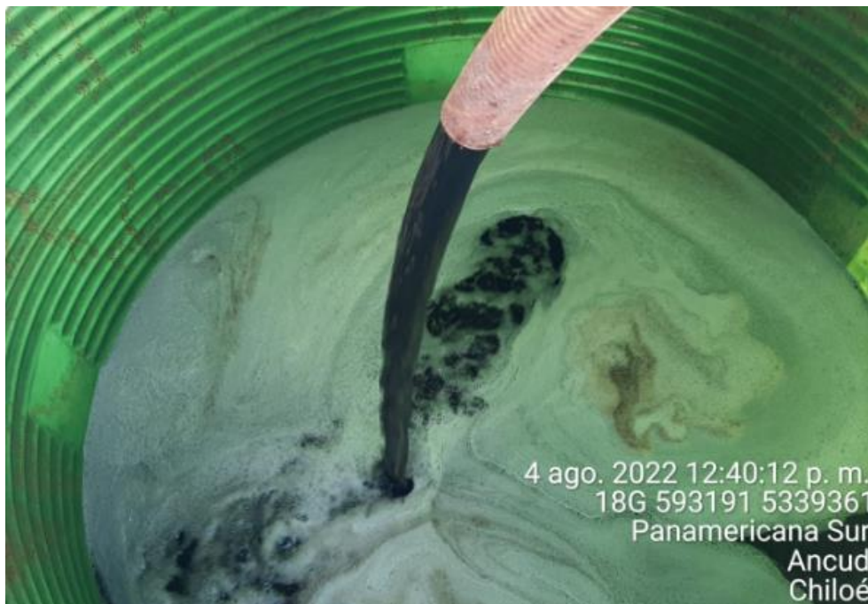
Fotografía N°12: Extracción de Lixiviados a estanque por personal municipal. Tomada: Jueves 04 de Agosto del 2022.
