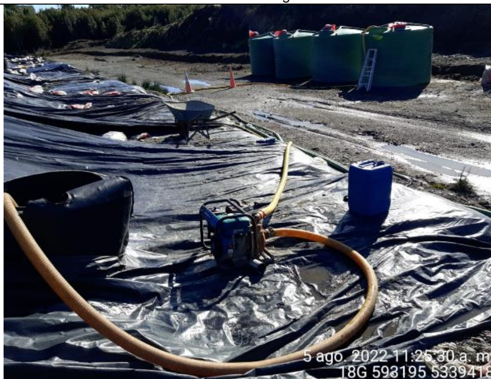
Fotografía N°15: Extracción de Lixiviados desde cámara C13. Tomada: Viernes 05 de Agosto del 2022.
