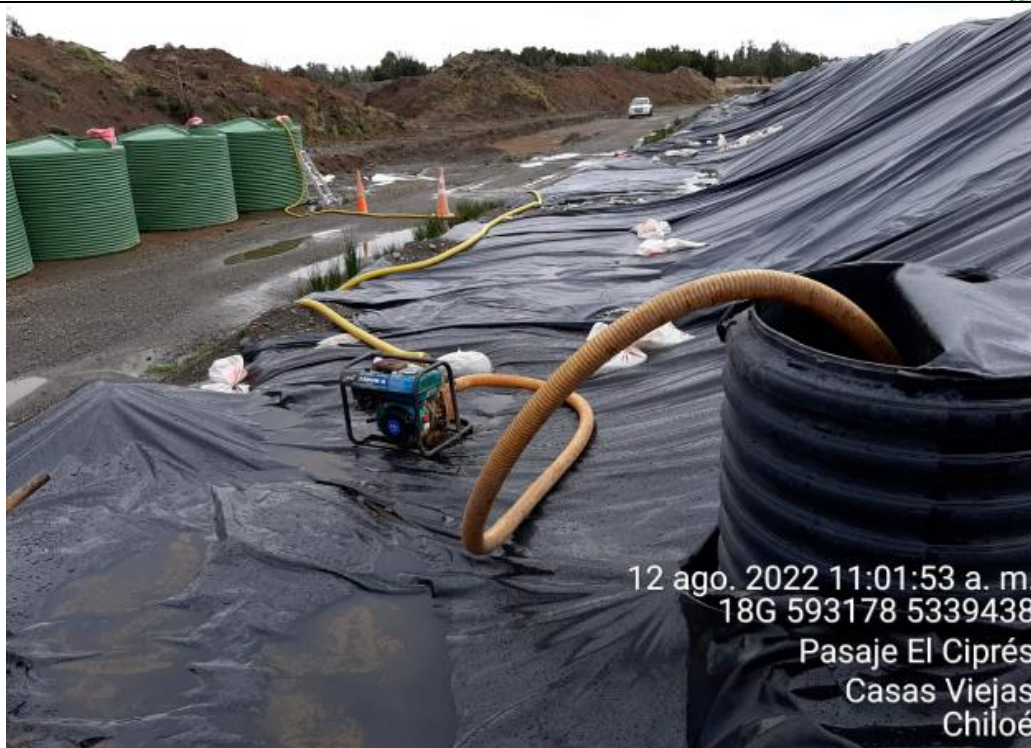
Fotografía N°32: Extracción de Lixiviados cámara C12. Tomada: Viernes 12 de Agosto del 2022.
