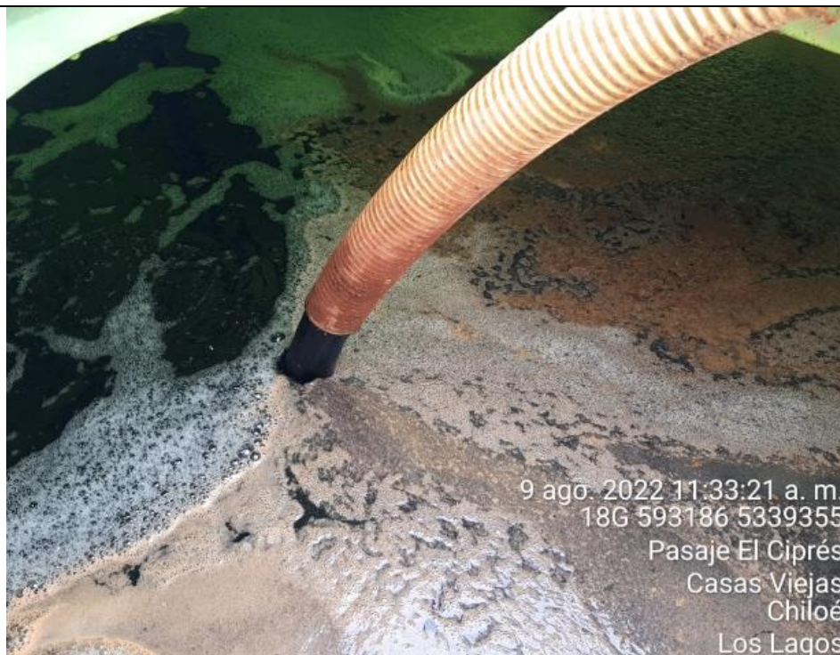
Fotografía N°26: Extracción de Lixiviados a estanque. Tomada: Martes 09 de Agosto del 2022.
