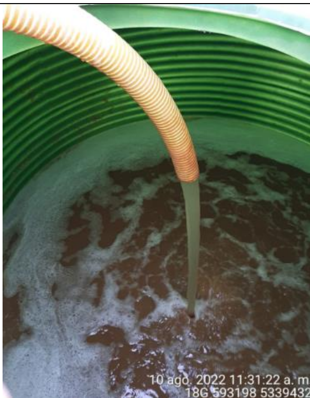
Fotografía N°29: Extracción de Lixiviados a estanque. Tomada: Miércoles 10 de Agosto del 2022.
