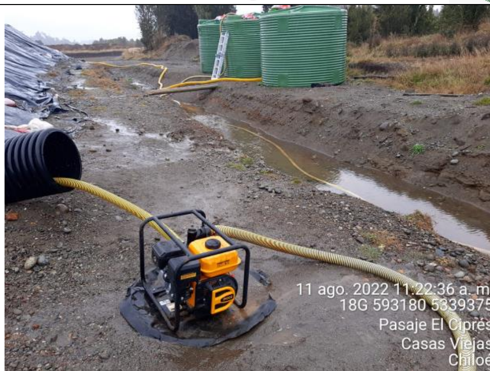
Fotografía N°30: Extracción de Lixiviados diagonal D02. Tomada: Jueves 11 de Agosto del 2022.
